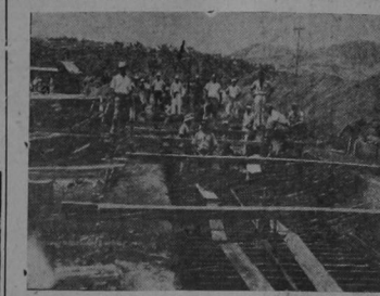
Levantando las paredes del último filtro: se trabaja activa y diligentemente.
